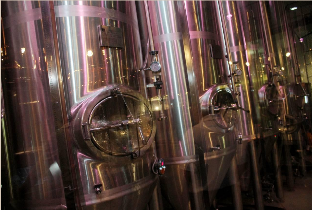
Zbiorniki cylindryczno - stożkowe do fermentacji i leżakowania piwa.
